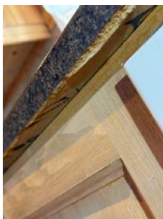
Bilde av svelling i underkant av benkeplaten.
