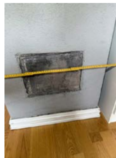
Bildet viser avstand til sotluke.
