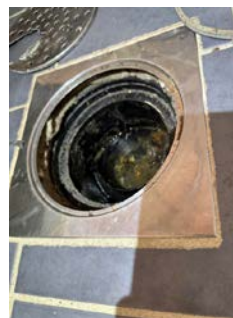
Bildet viser sluk under dusjkabinettet.
