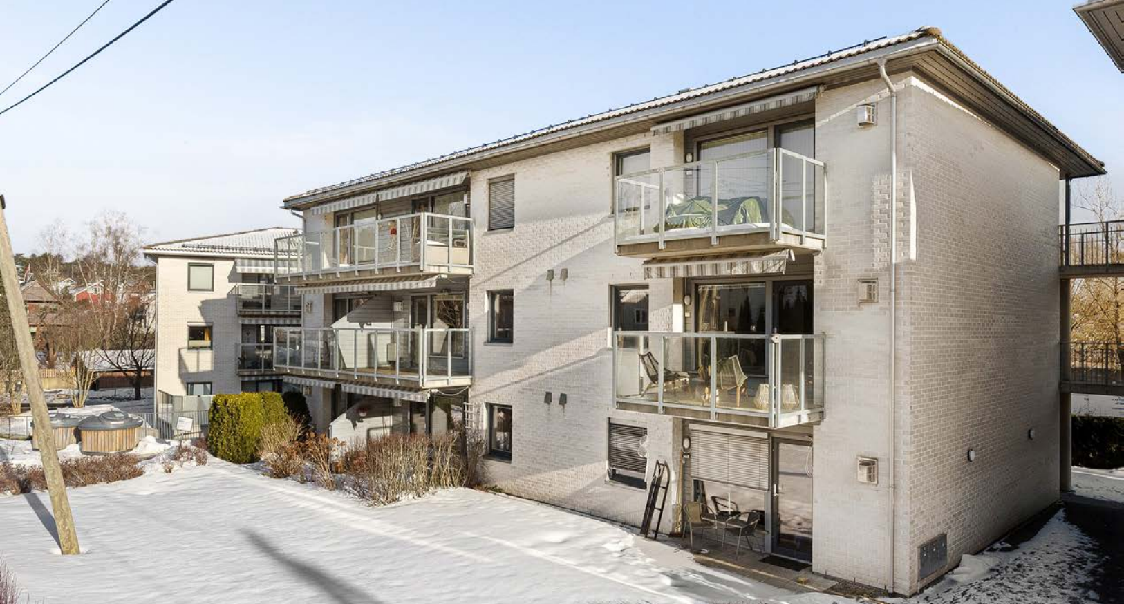
Sameiet har velholdte bygninger oppført i 2009 med fin teglsteinsfasade.
