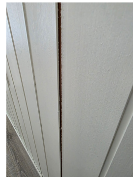
Løse takplater i kjeller. Takplatene er forsøkt utbedret med synlige skruer.
