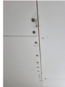
Løse takplater i kjeller. Takplatene er forsøkt utbedret med synlige skruer.
