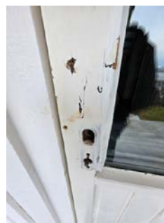
Balkongdør i kjeller lar seg ikke betjene
