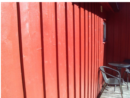
Bra vedlikeholdt med maling.
