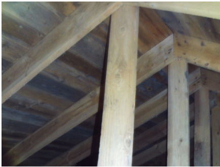
Deler av takkonstruksjonen.
