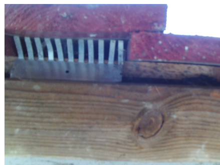
Lufting på fasader som er nye eller byttet
