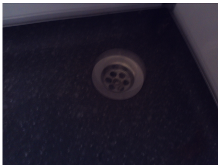
Et mindre avløpsrør med sluk
