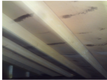
Sutakplater som undertak på tilbygget del.
