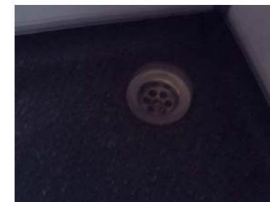
Et mindre avløpsrør med sluk
