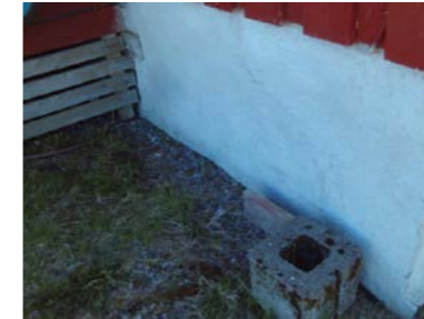
Deler av pusset ringmur.
