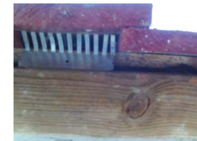
Lufting på fasader som er nye eller byttet
