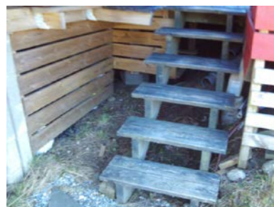
Trapp på ene siden av terrasse i front
