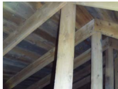
Deler av takkonstruksjonen.
