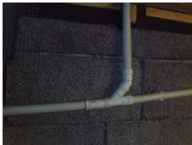
Avløpsrør i krypkjeller.
