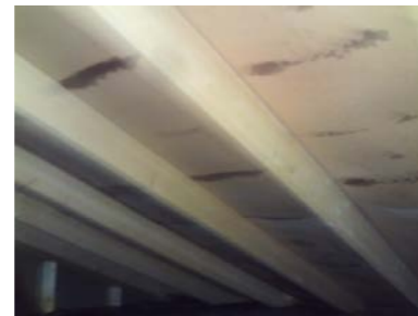
Sutakplater som undertak på tilbygget del.
