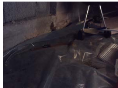
Er lagt en plastduk for å hindre at noe jordfuktighet kommer opp.
