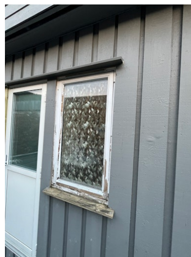
Utvendig vindu på bad
