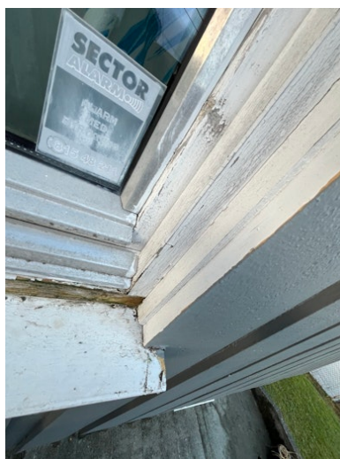
Vindu på vaskerom
