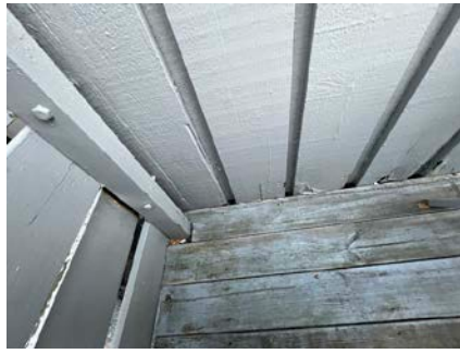
Ved terrasse med soverom
