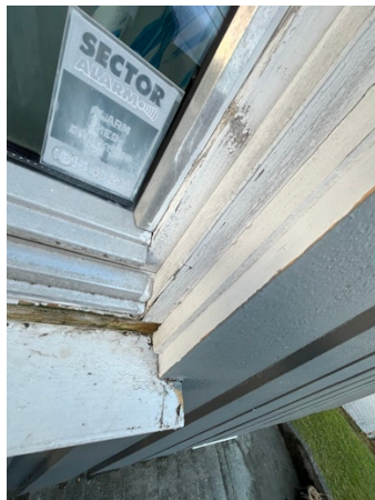
Vindu på vaskerom
