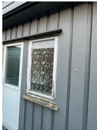
Utvendig vindu på bad
