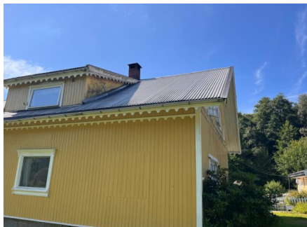
Gjenkledd vindu, panel skjøtet inn.
