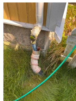
Nedløp bør tilkobles røret fra grunn.
