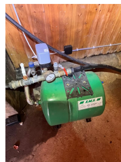
Dårlig festede rør, ufagmessig utførelse.
