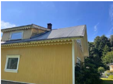
Gjenkledd vindu, panel skjøtet inn.
