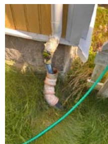
Nedløp bør tilkobles røret fra grunn.
