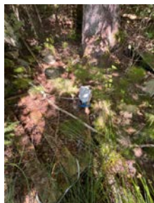
Brønn og koblingsboks for brønnpumpe.
