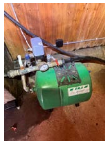
Dårlig festede rør, ufagmessig utførelse.
