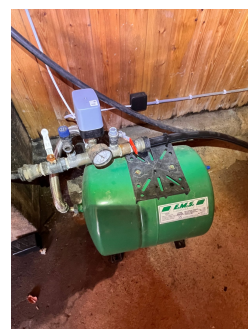
Dårlig festede rør, ufagmessig utførelse.
