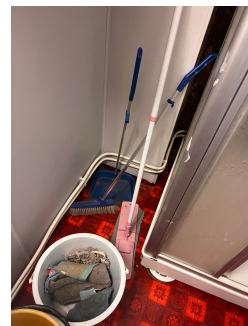
Dårlig festede rør, ufagmessig utførelse.
