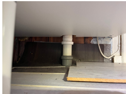
Dårlig festet kabel.
