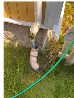
Nedløp bør tilkobles røret fra grunn.
