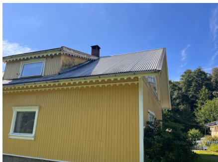
Gjenkledd vindu, panel skjøtet inn.
