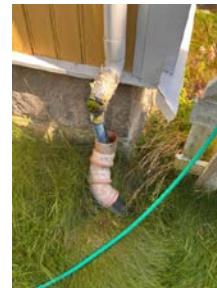
Nedløp bør tilkobles røret fra grunn.
