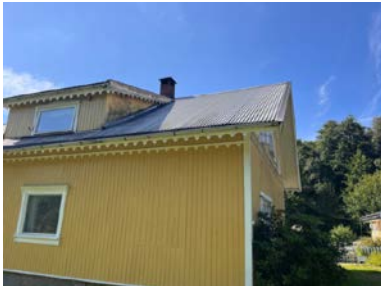
Gjenkledt vindu, panel skjøtet inn.
