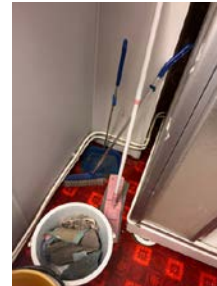
Dårlig festede rør, ufagmessig utførelse.
