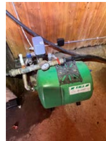
Dårlig festede rør, ufagmessig utførelse.
