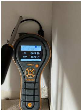
Måling av relativ luftfuktighet.
