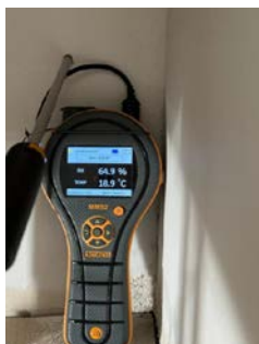
Måling av relativ luftfuktighet.
