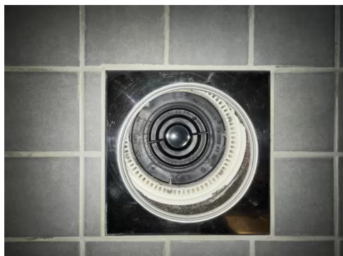
Viser sluk i dusjsonen.
