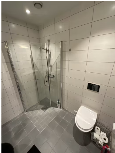
Viser dusjsone og vegghengt toalett med innebygget sisterner.
