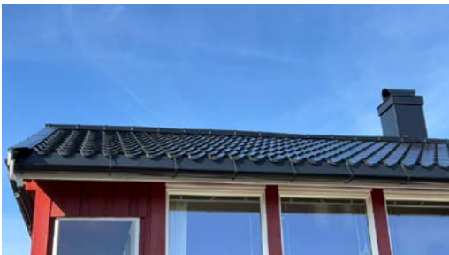
Del av taktekkning.
