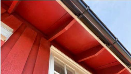
Del av takkonstruksjon.
