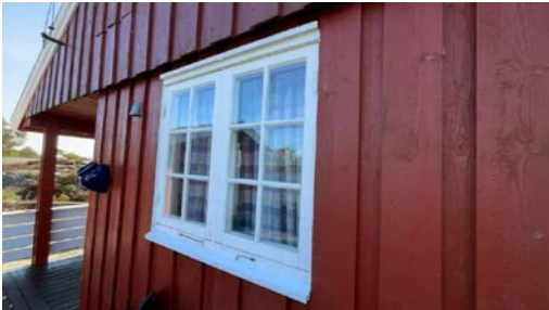
Eksempel på vindu i yttervegg.
