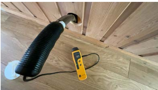
Hull for kontroll av fukt.
