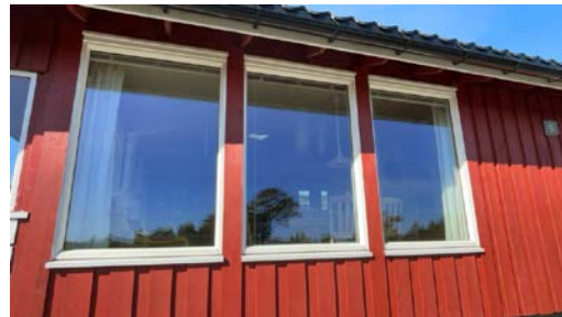
Eksempel på vindu i yttervegg.
