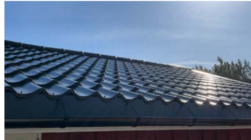
Del av taktekkning.
