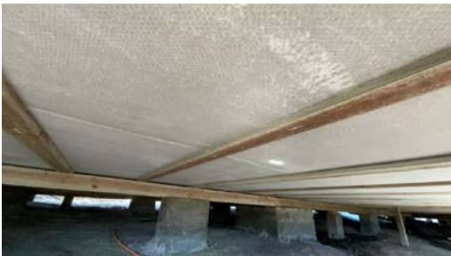
Del av etasjeskille sett fra undersiden.
