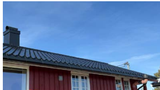
Del av taktekkning.
