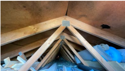
Del av takkonstruksjon, sett fra loft.
