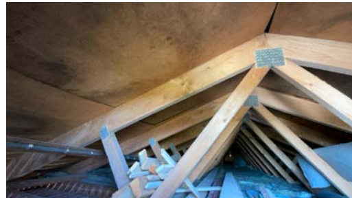
Del av takkonstruksjon, sett fra loft.
