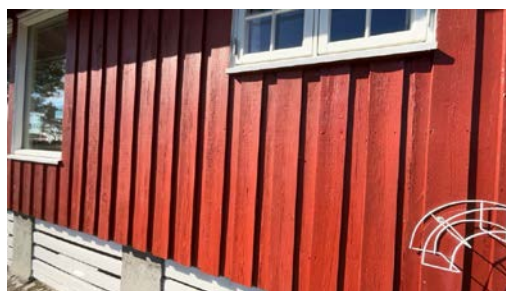
Del av vegg.
