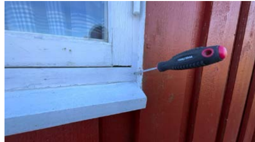
Stikk kontroll på vinduer er utført.
