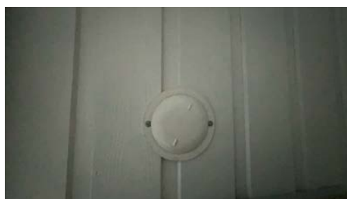
Eksempel på montert ventil i vegg.
