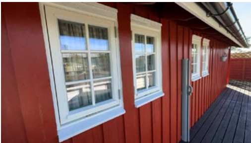
Eksempel på vindu i yttervegg.
