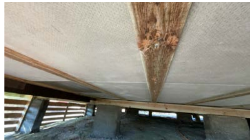
Del av etasjeskille sett fra undersiden.
