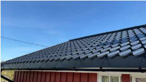
Del av taktekkning.
