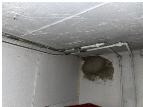
Inspeksjonslukke tettet med skruer og fuget/skummet igjen.
