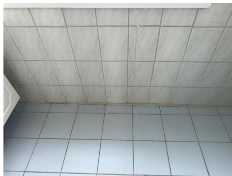
Sprekker og løse gulv/veggfliser.
