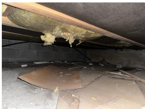
Asfaltplater falt ned
