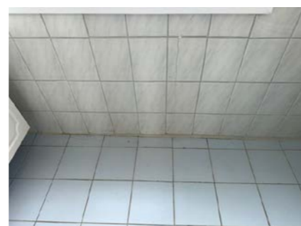
Sprekker og løse gulv/veggfliser.
