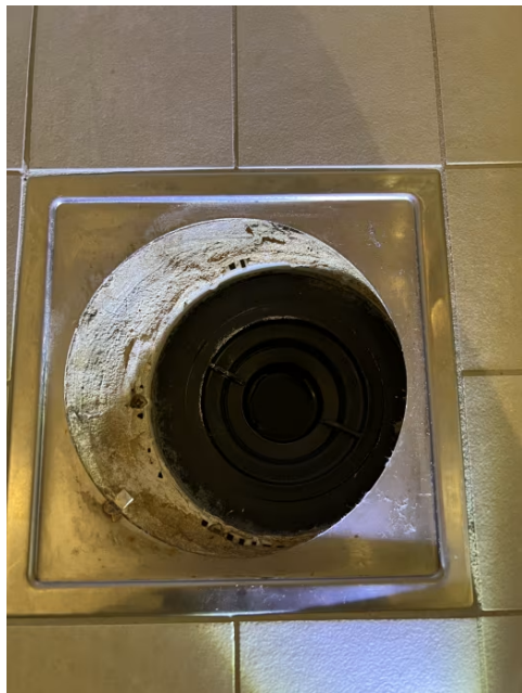
Membran er synlig ført under klemring.
