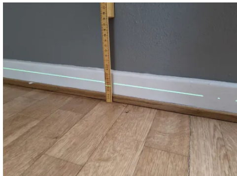
Etasjeskillet er kontrollert med nivelleringslaser.
