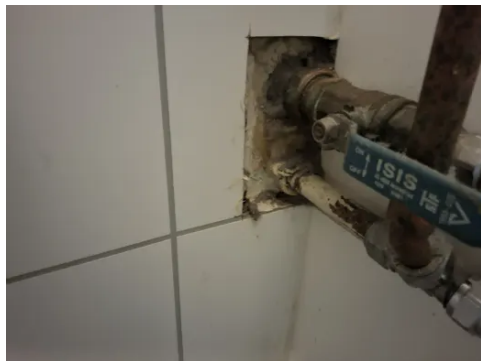
Rørgjennomføringer er tettet med fugemasse.
