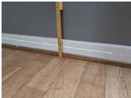
Etasjeskillet er kontrollert med nivelleringslaser.
