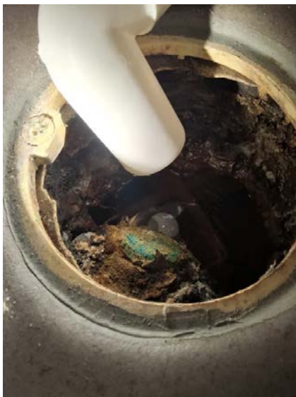
Eldre støpejernssluk.
