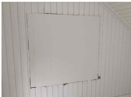
Tidligere vindu er tett med plate.
