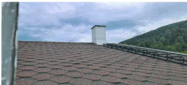
Takstige opp til pipe for feier.
