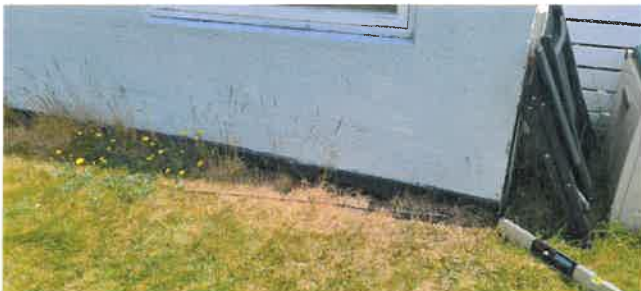
Bilde viser knotteplast med topplist på baksiden av bolig.
