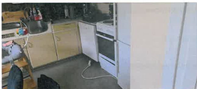
Bilde av kjøkkeninnredning hvor skjøteledning er synlig på gulv.
