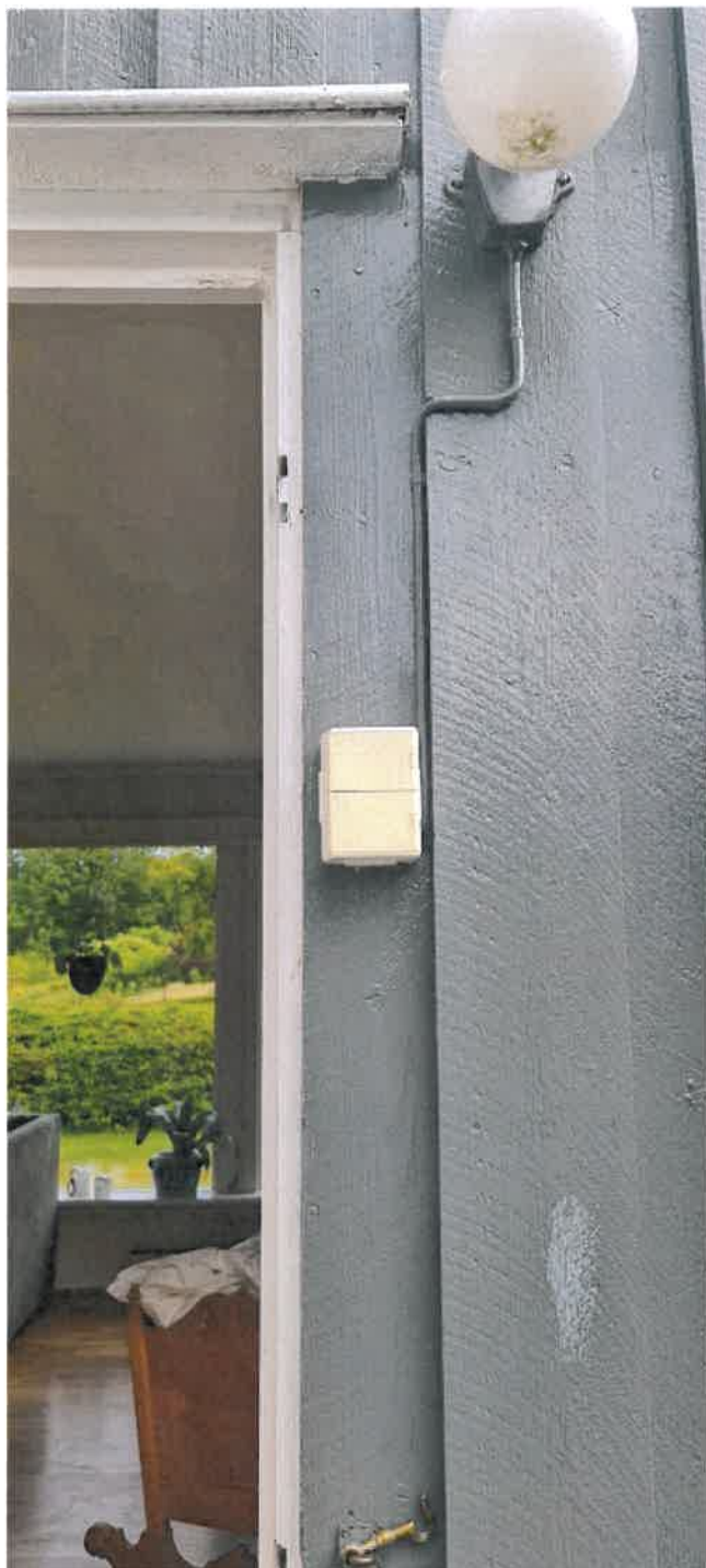
Stikkontakt ved terrassedør er feil montert; den drenerer ikke ut eventuelt fuktighet.
