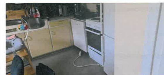
Bilde av kjøkkeninnredning hvor skjøteledning er synlig på gulv.
