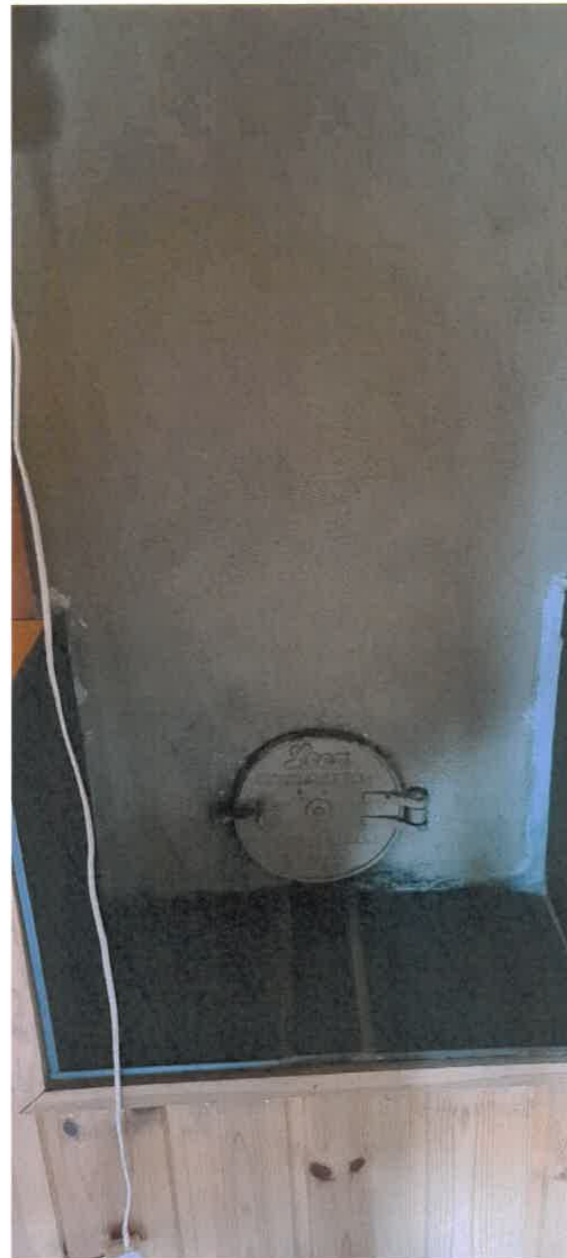
Feieluke hvor det er montert flis under og på siden av feieluke.
