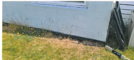
Bilde viser knotteplast med topplast på baksiden av bolig.
