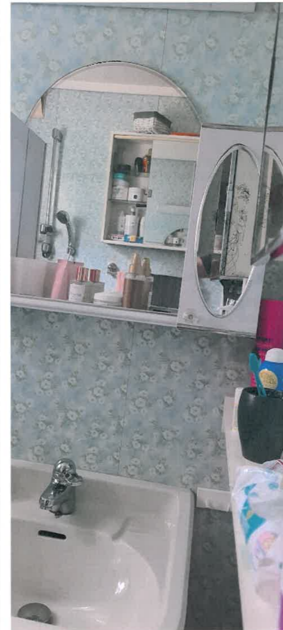
Servant på vegg med speilskap over.
