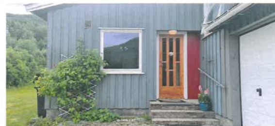
Ytterdør på bolig med eternittplater på høyre side.
