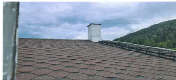
Takstige opp til pipe for feier.
