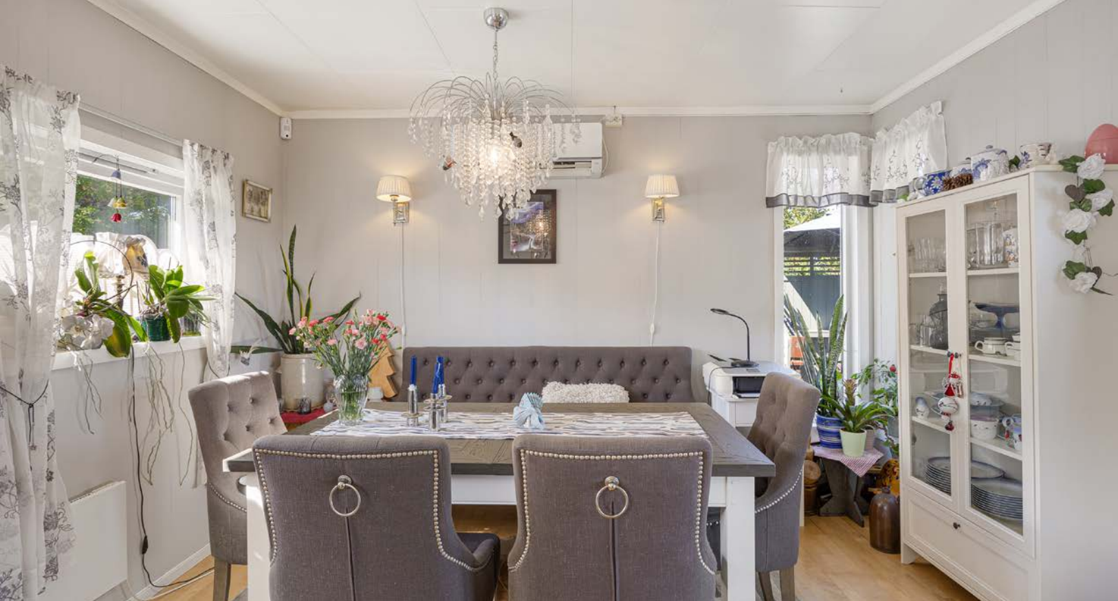
Boligen har to varmepumper fra henholdsvis 2017 og 2018.
