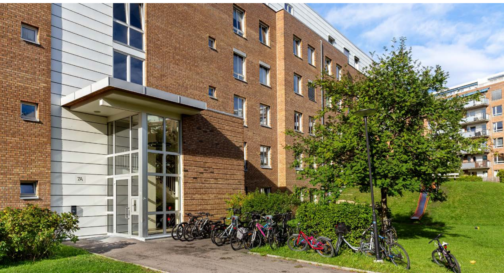
Inngangsparti med med mulighet for adkomst med heis til leiligheten.
