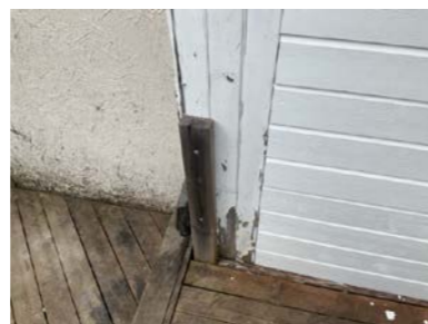
Malingsflass synlig på hjørnekasse.
