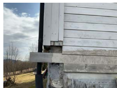
Manglende komplettering av hjørnekasse.
