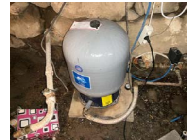
Trykktank montert i kjeller.
