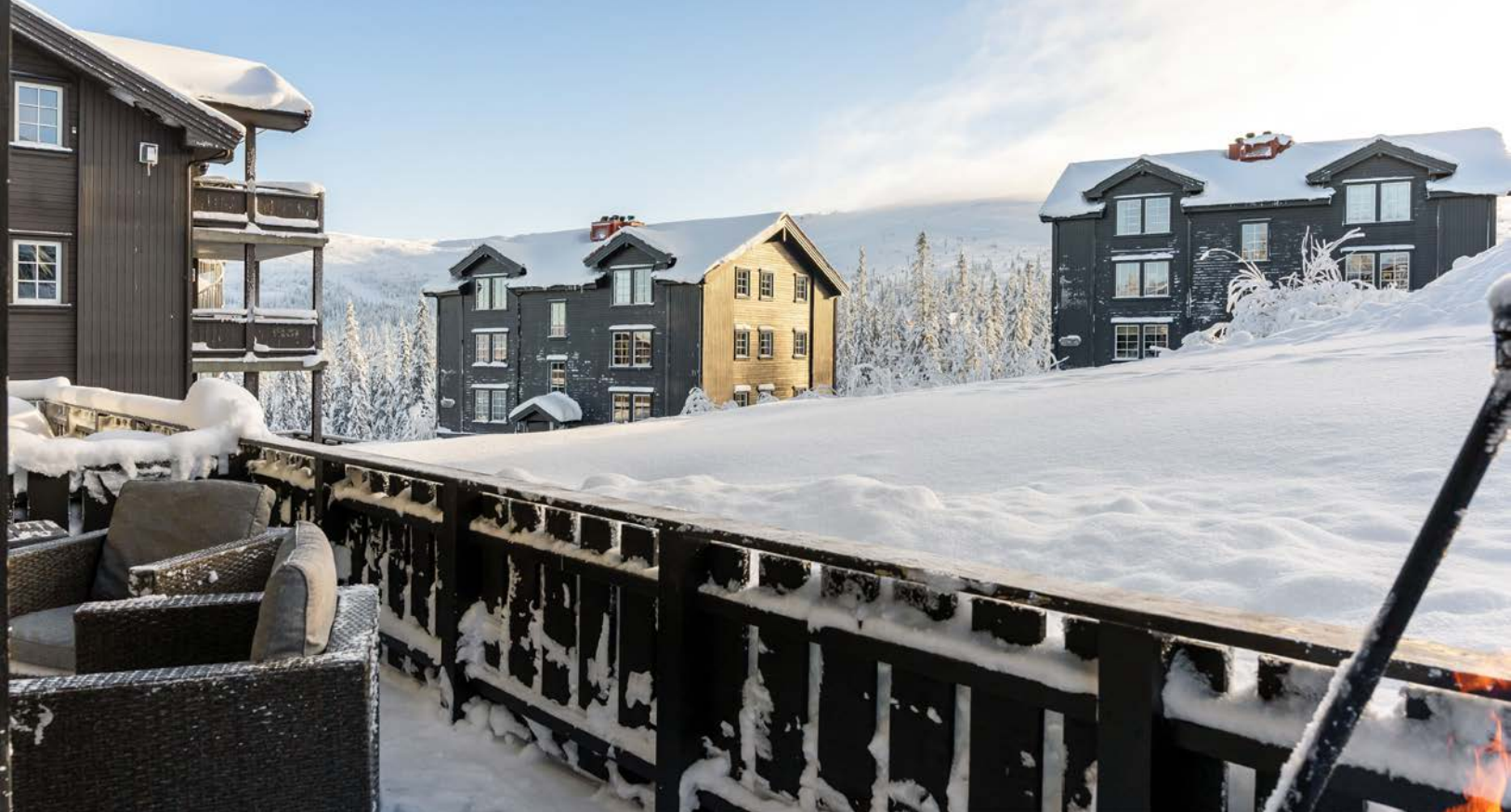
Terrassen er delvis overbygget og har terrassebord på gulv.
