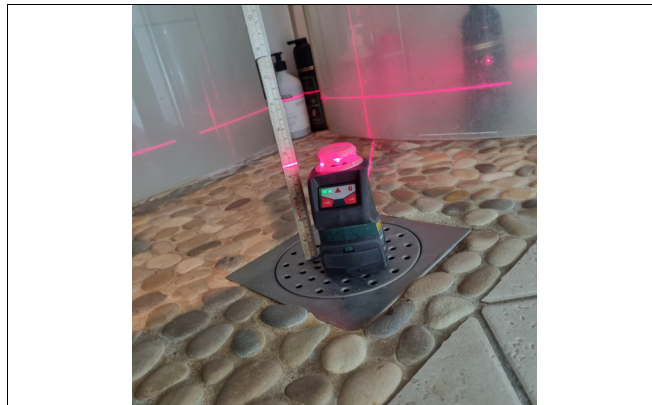
Kontroll av fall mot sluk på badegulv.
