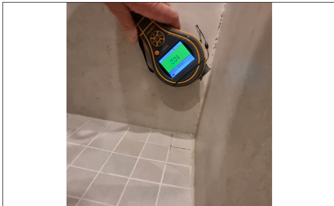
Kontrolløk med fuktmåler i dusjonen.
