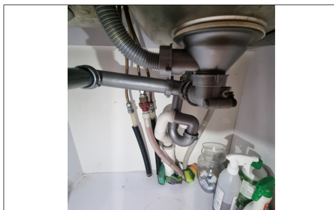
Kontroll av røropplegg i kjøkkenbenk.
