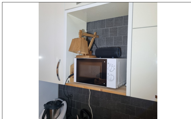
Mangler ventilator på kjøkken til utleiedel.
