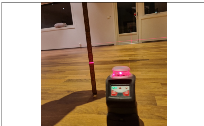
Nivellering av gulv, og kontroll av eventuelle skjevheter.
