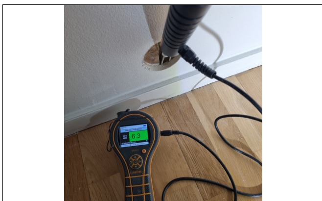
Hullboring og kontroll av hulrom i vegg mot våtsone.
