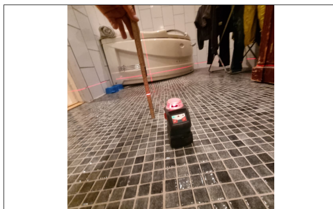
Kontroll av fall mot sluk på badegulv.
