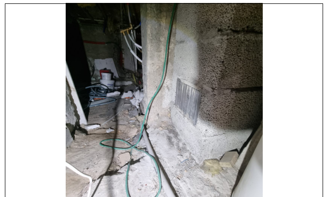
Kontroll av krypkjeller.
