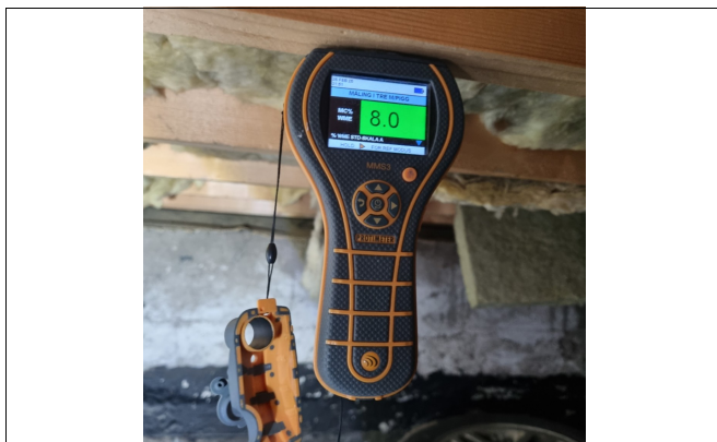
Kontroll med fuktmåler i bjelkelag krypkjeller. OK fuktmålinger.
