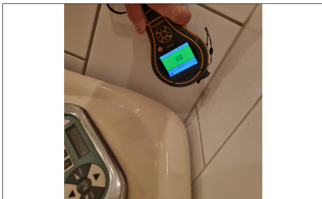
Kontrollsjøk med fuktmåler i dusjsonen.
