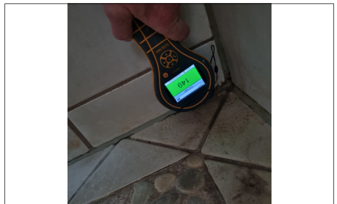
Kontrollseek med fuktmåler i dusjsonen.
