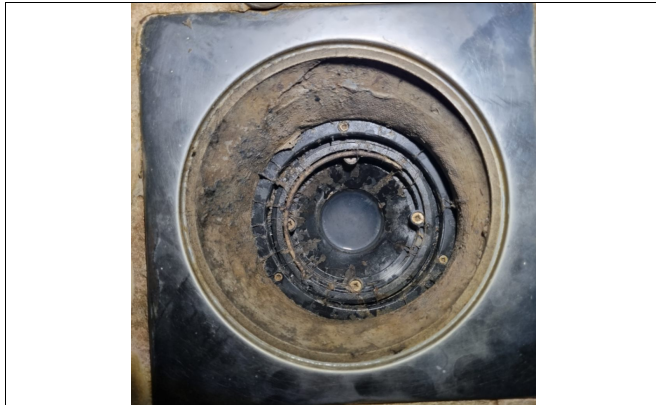
Kontroll av sluk.
