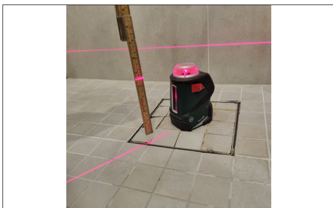
Kontroll av fall på badegulv.
