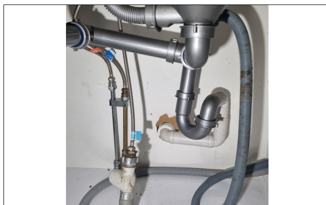
Kontroll av røropplegg i kjøkkenbenk.
