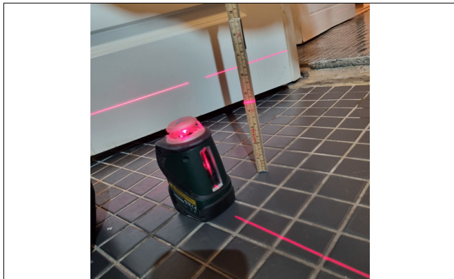
Kontroll av fall mot sluk på badegulv.
