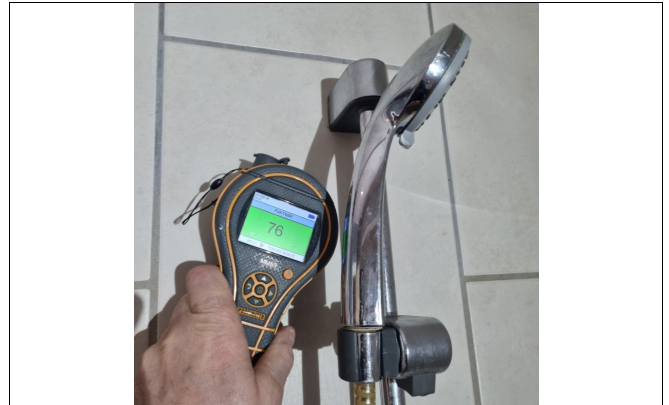
Kontrollseek med fuktmåler i dusjsonen.
