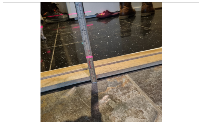
Kontroll av fall mot sluk på badegulv.
