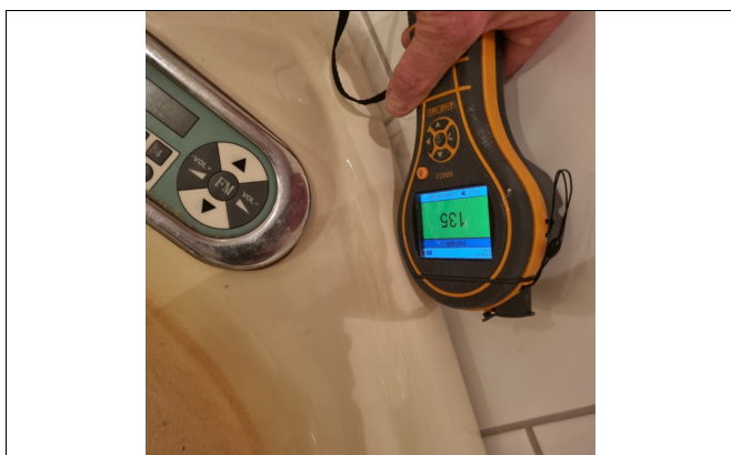
Kontrollsjøk med fuktmåler i dusjsonen.
