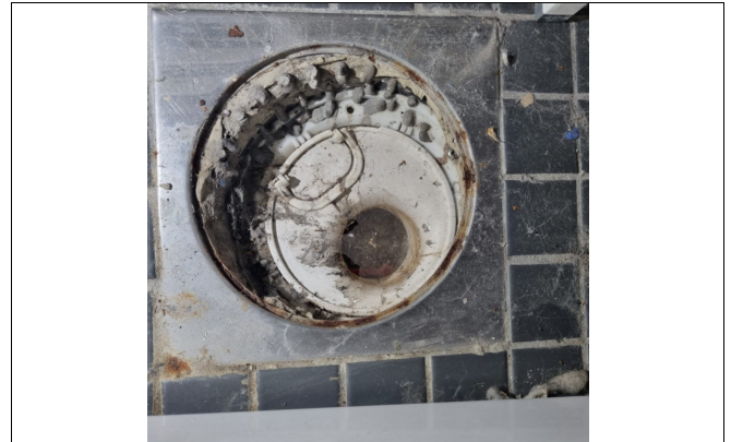
Kontroll av sluk.
