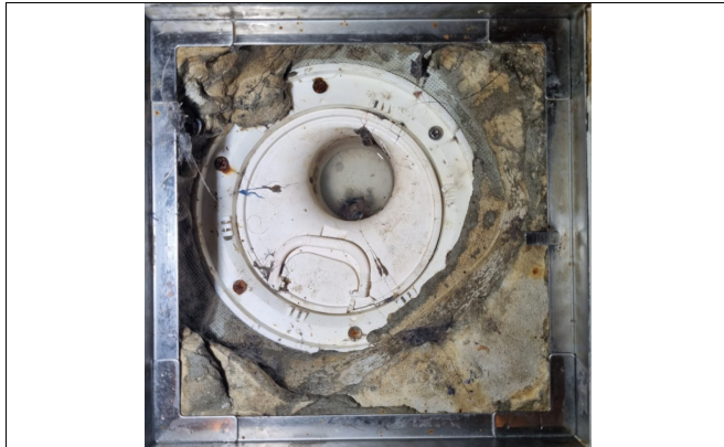
Kontroll av sluk.
