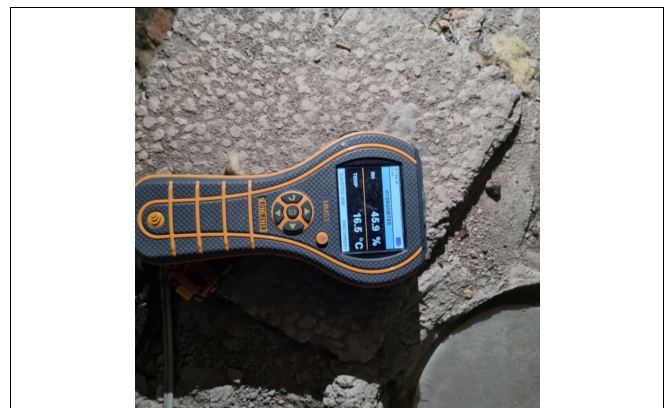
Målt RF og temp i krypkjeller. OK:
