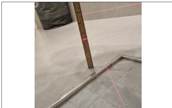
Kontroll av fall mot sluk på badegulv.
