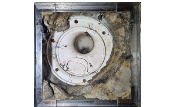
Kontroll av sluk.
