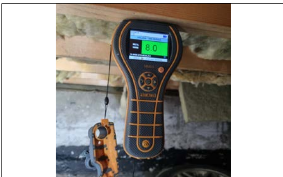
Kontroll med fuktmåler i bjelkelag krypkjeller. OK fuktmålinger.
