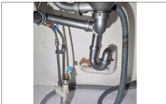
Kontroll av røropplegg i kjøkkenbenk.
