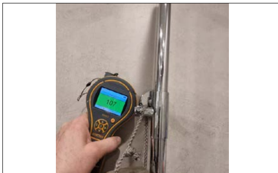
Kontrollsjøk med fuktmåler i dusjsonen.
