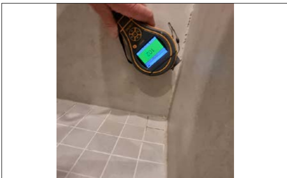
Kontrollsøk med fuktmåler i dusjsonen.
