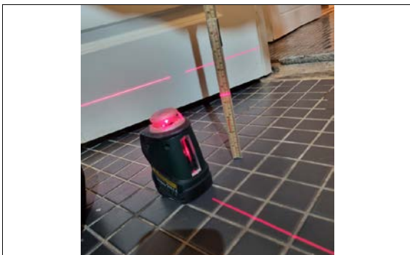
Kontroll av fall mot sluk på badegulv.
