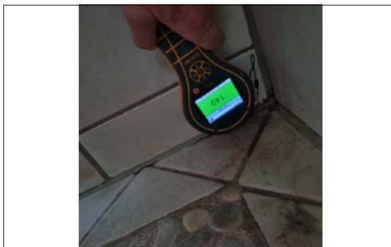
Kontrollseek med fuktmåler i dusjsonen.
