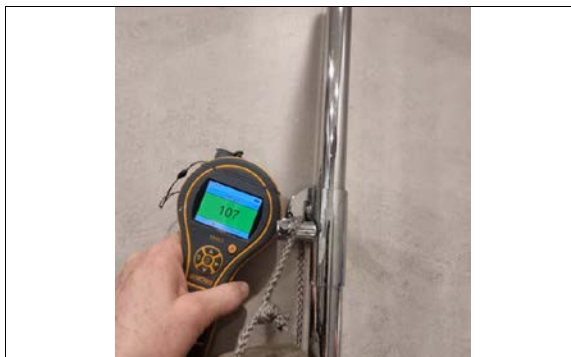
Kontrolløk med fuktmåler i dusjsonen.
