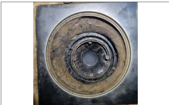
Kontroll av sluk.
