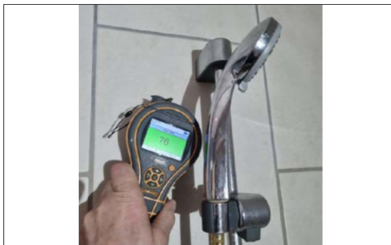
Kontrollseek med fuktmåler i dusjsonen.
