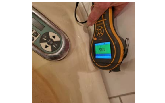
Kontrollsløk med fuktmåler i dusjsone.
