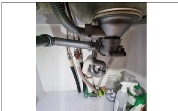
Kontroll av røropplegg i kjøkkenbenk.
