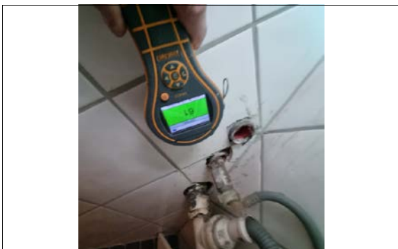
Kontrollseek med fuktmåler i dusjsonen.
