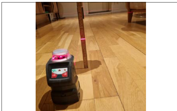
Nivellering av gulv, og kontroll av eventuelle skjevheter.
