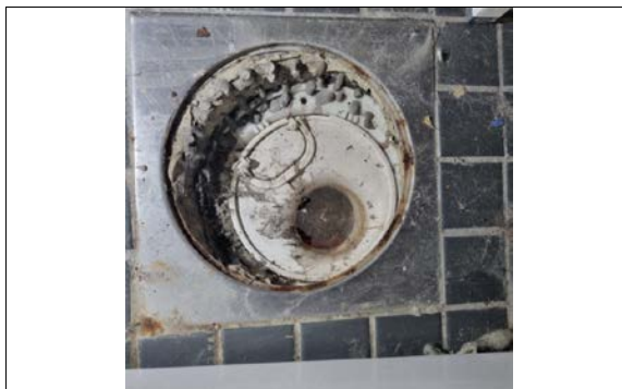
Kontroll av sluk.
