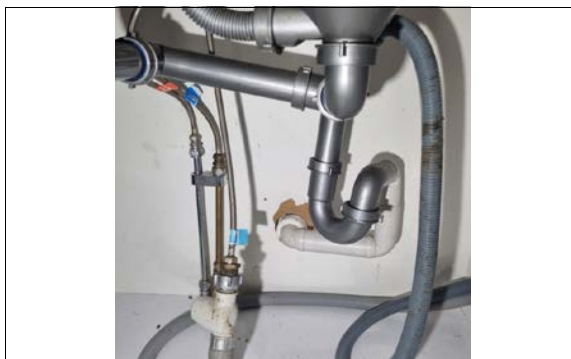
Kontroll av røropplegg i kjøkkenbenk.
