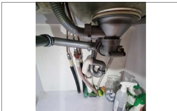
Kontroll av røropplegg i kjøkkenbenk.
