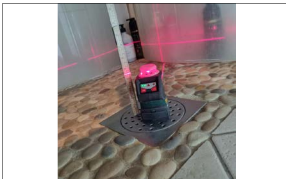
Kontroll av fall mot sluk på badegulv.
