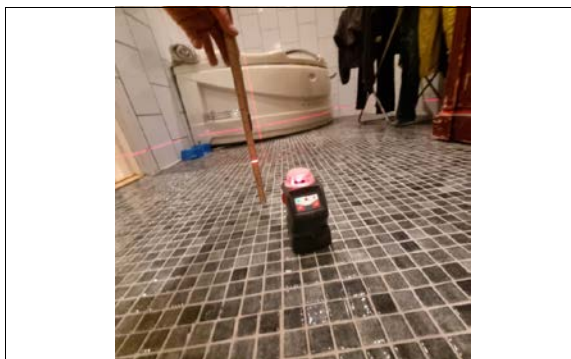
Kontroll av fall mot sluk på badegulv.
