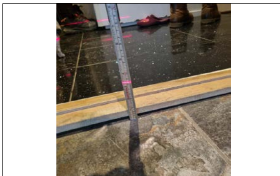
Kontroll av fall mot sluk på badegulv.
