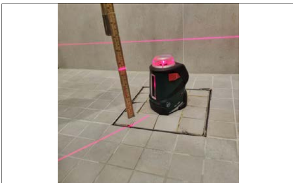
Kontroll av fall på badegulv.
