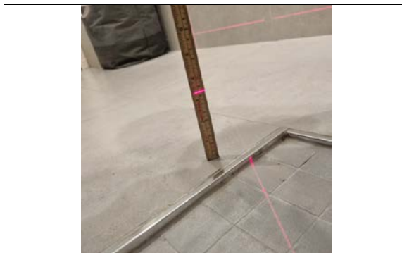
Kontroll av fall mot sluk på badegulv.
