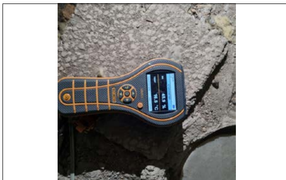
Målt RF og temp i krypkjeller. OK:
