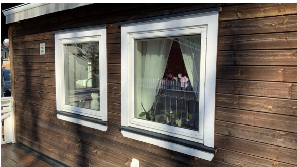
Vinduer mot øst
