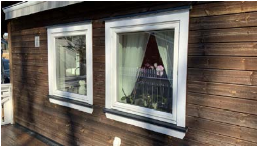
Vinduer mot øst
