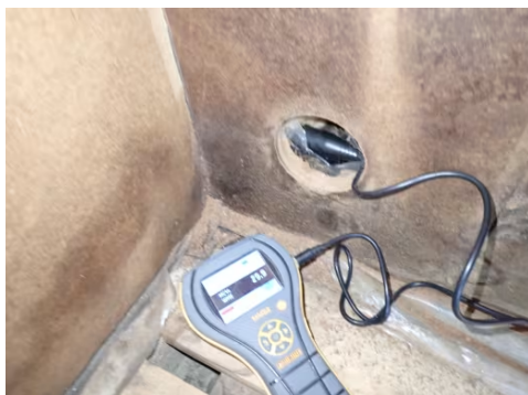
Måling ved konstruksjon i bod som i dag er fjernet.
