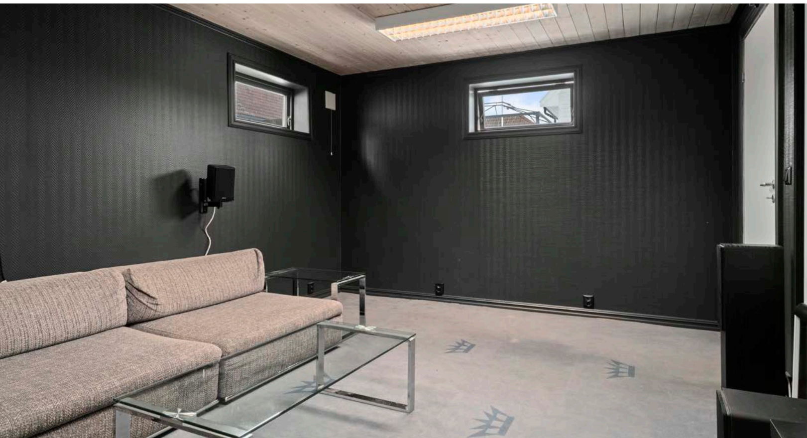
Innredet rom/kjeller som av dagens eier er tatt i bruk som kjellerstue (ikke omsøkt og godkjent som rom til varig opphold).
