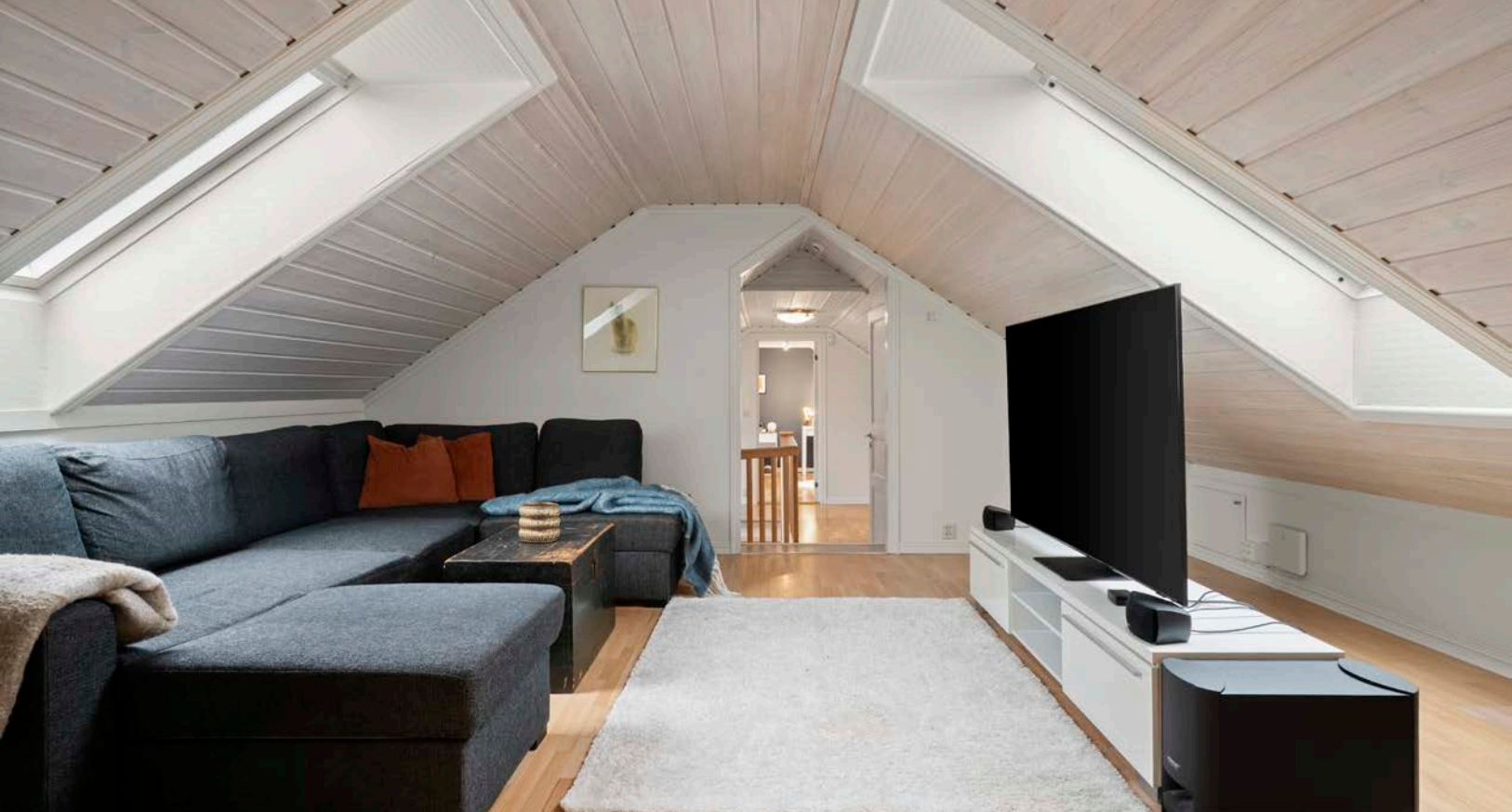
Innredet rom/loft som av dagens eier er tatt i bruk som stue (ikke omsøkt og godkjent som rom til varig opphold).
