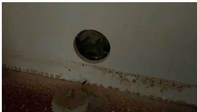
U. ETASJE > VASKEROM
