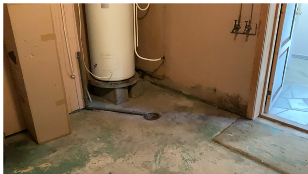
U. ETASJE > VASKEROM
