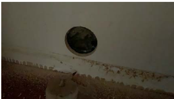
U. ETASJE > VASKEROM
