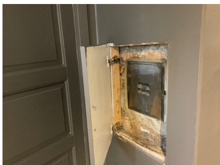
Luke i brennbart materiale plassert foran feieluke.
