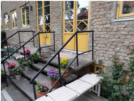
Trapp med rekkverk.
