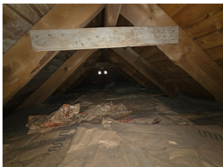
Ventilering av takkonstruksjon er synlig oppe på gavelvegg
