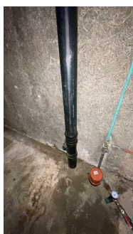
Stakeluke er tilgjengelig inne på kjellerbod
