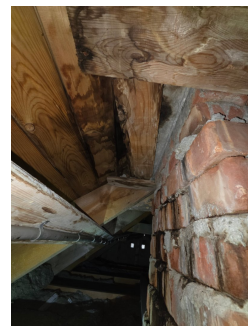
Fuktmerker er synlige på underpanel ved pipe. Ingen fukt på befaringsdagen
