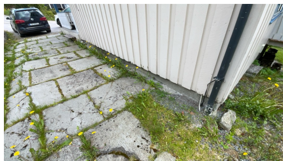
På oversiden er det synlig støpt på grunnmur
