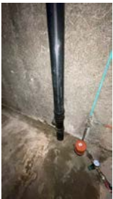
Stakeluke er tilgjengelig inne på kjellerbod
