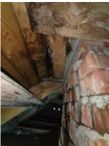
Fuktmerker er synlige på underpanel ved pipe. Ingen fukt på befaringsdagen
