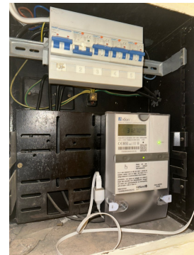
Sikringskap med automatsikringer.
