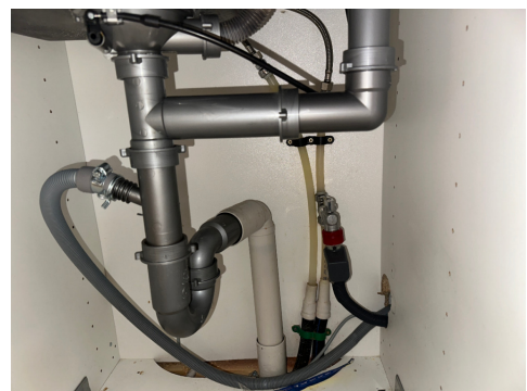
Rørproppleg i kjøkkenbenk
