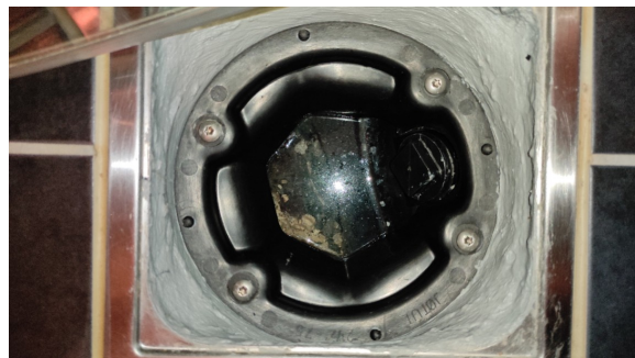
Kontroll av sluk.
