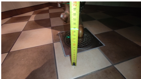
Kontroll av fallforhold.
