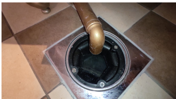
Kontroll av sluk.
