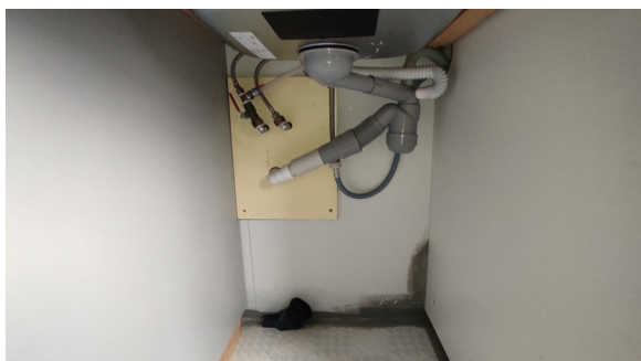
Kontroll av røropplegg.
