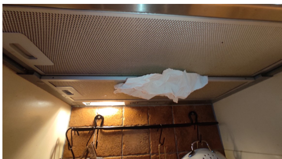
Test av avtrekket.
