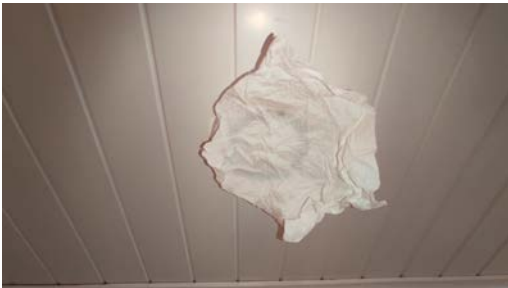
Test av avtrekket.
