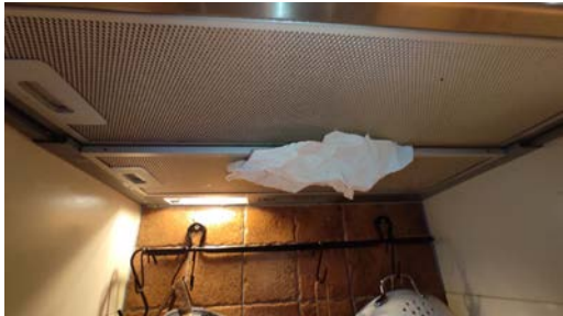
Test av avtrekket.
