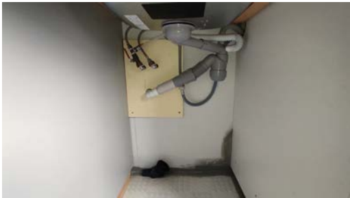
Kontroll av røropplegg.
