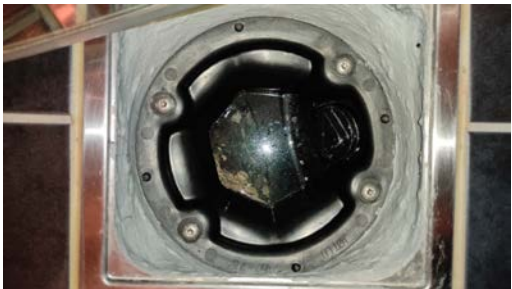
Kontroll av sluk.
