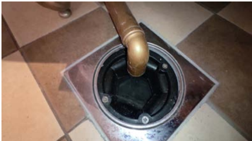
Kontroll av sluk.
