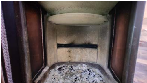
Kontroll av ildsted
