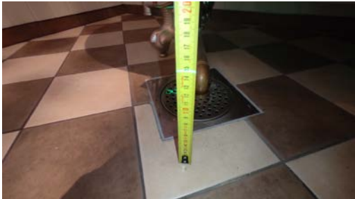
Kontroll av fallforhold.
