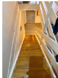
Bildet viser trapp ned til kjelleren.
