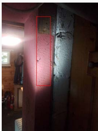
Flygehull fra stripet borebille i dørstokk.framstår ikke som nye.
