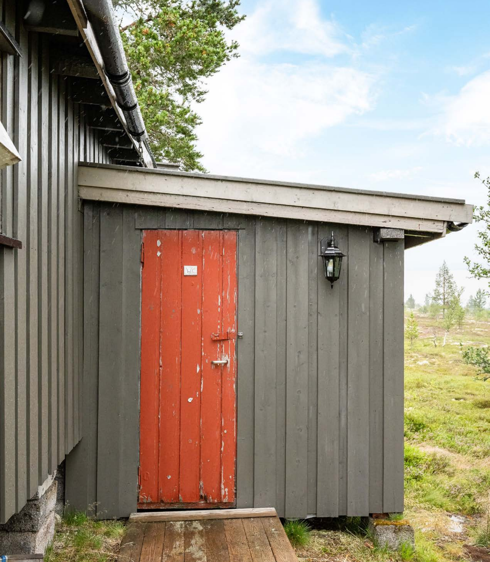
Inntilbygget uted med grovt tregulv.
