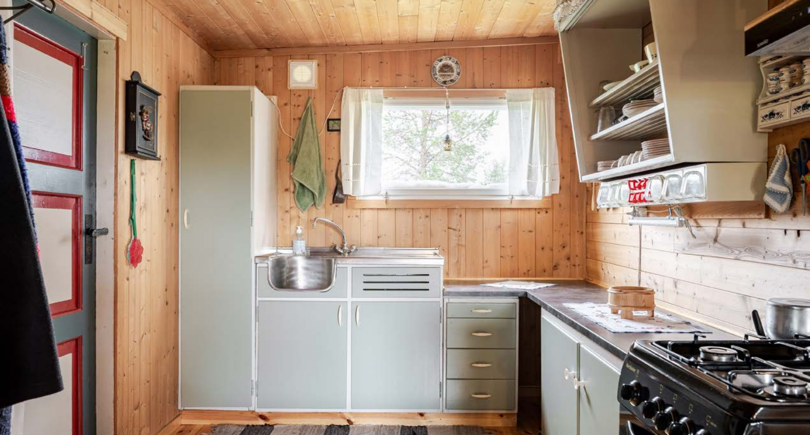
Eldre kjøkkeninnredning med glatte malte fronter, laminert benkeplate og benkebeslag med oppvaskkum (avløp til terreng).
