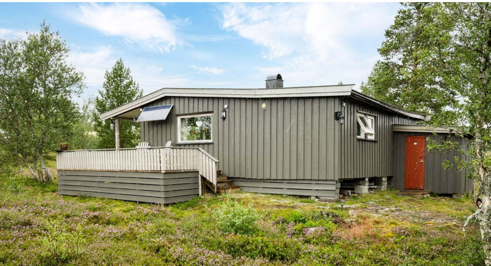
Hytta er vedlikeholdt med bla. nytt tak i ca. 2021, samt ny ytterkledning, isolasjon og vindsperre i ca. 2019.
