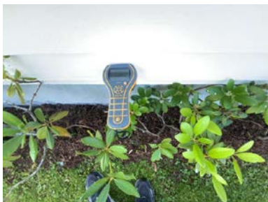
Ved enkel fuktmåling mot nord registrerte jeg tørre verdier.
