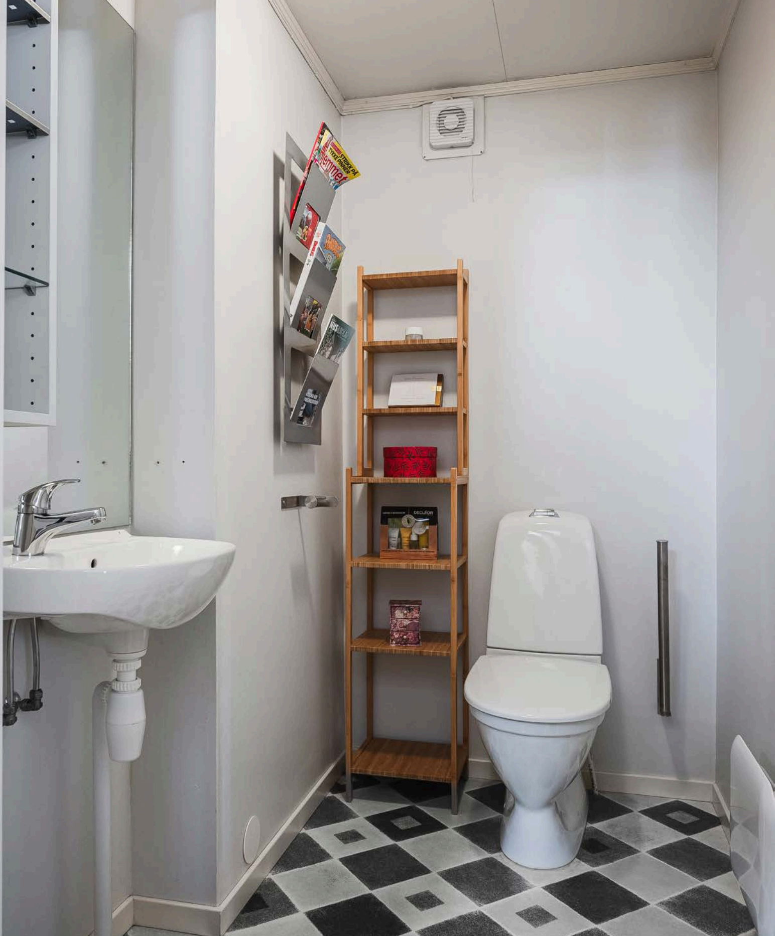
Toalettrom i sokkel med vinylbelegg på gulv og malte veggplater. Installasjoner med håndvask og gulvstående toalett. Det er også et vaskerom i etasjen med betonggulv og malt strietapet. Vaskerommet har skyllekar og opplegg for vaskemaskin.
