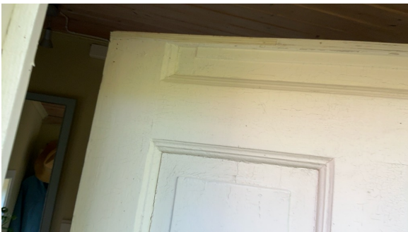
Ytterdør kappet av på høyden.
