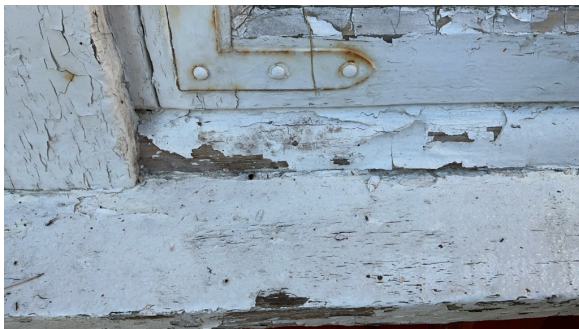
Karmene i vinduer er slitte og det er sprekker i trevirket.
