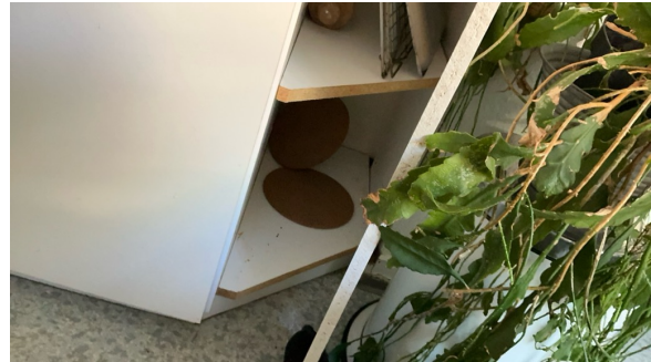
Hyller og dør med ender av sponplate
