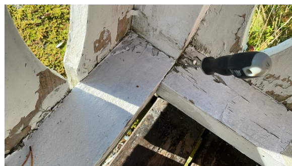
Fukt/råte skade
